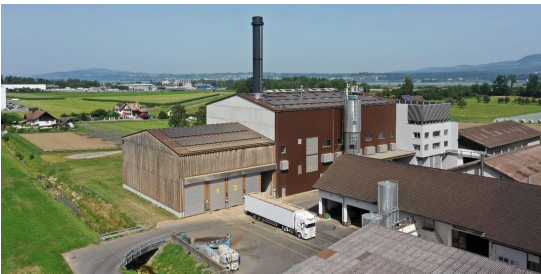
Centrale de chauffage au bois
