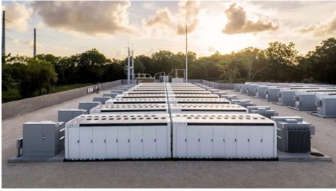
Grössere Netzspeicher werden modular aufgebaut. Mehrere Firmen bieten Module in Container-Grösse an, jeweils mit Kapazitäten von ca. 5 MWh. Diese werden zu Speicherfarmen zusammengesetzt. Bild links: Tesla MEGAPACK 10 . Bild rechts: BYD CUB 11 .
