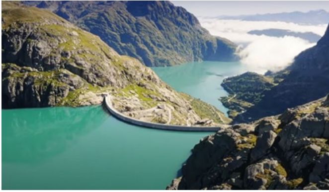
Bild links: Pumpspeicherwerk Nant de Drance. Oberer See Vieux Emosson, 2'225 m (25 Mio m 3 Wasser, 20 GWh elektrische Speicher). Unterer See: Lac d'Emosson, 1'930 m. Bild rechts: Das Pumpspeicherkraftwerk Linth-Limmern ist das grösste der Schweiz. Der Mutsee, 2'474 m (23 Mio m 3 Wasser, 33 GWh el. Speicher) ist der höchstgelegene Stausee Europas. Unterer See: Limmensee, 1'857 m (Fotos und Zahlen 3 )
