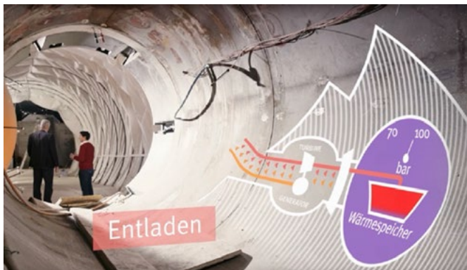
Laden und Entladen des adiabatischen Druckluftenergiespeichers auf 70 bis 100 bar (©Schweizerischer Nationalfonds SNF).
