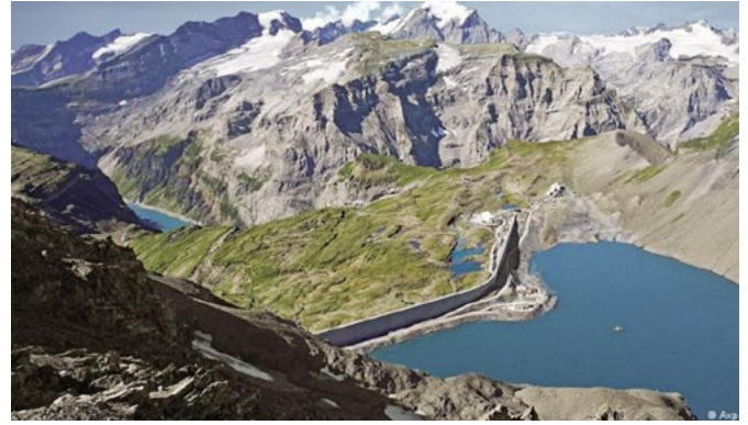
Bild links: Pumpspeicherwerk Nant de Drance. Oberer See Vieux Emosson, 2'225 m (25 Mio m 3 Wasser, 20 GWh elektrische Speicher). Unterer See: Lac d'Emosson, 1'930 m. Bild rechts: Das Pumpspeicherkraftwerk Linth-Limmern ist das grösste der Schweiz. Der Mutsee, 2'474 m (23 Mio m 3 Wasser, 33 GWh el. Speicher) ist der höchstgelegene Stausee Europas. Unterer See: Limmensee, 1'857 m (Fotos und Zahlen 3 )
