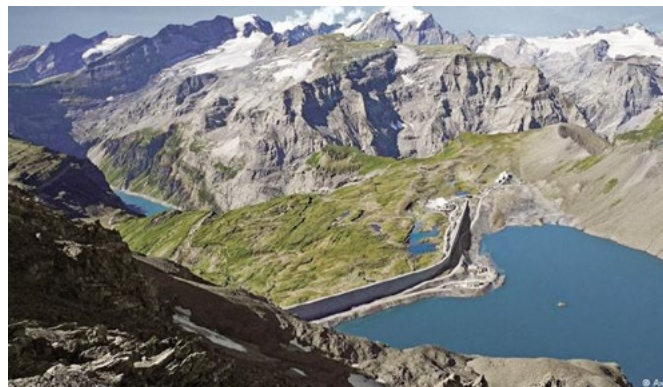
Photo de gauche : Centrale de pompage-turbinage de Nant de Drance. Lac supérieur Vieux Emosson, 2'225 m (25 millions de m 3 d'eau, 20 GWh de stockage électrique). Lac inférieur : Lac d'Emosson, 1'930 m. Photo de droite : la centrale de pompage-turbinage de Linth-Limmern est la plus grande de Suisse. Le lac de Mutt, 2'474 m (23 millions de m 3 d'eau, 33 GWh de stockage électrique) est le lac de retenue le plus haut d'Europe. Lac inférieur : Limmerensee, 1'857 m (photos et chiffres ) 3
