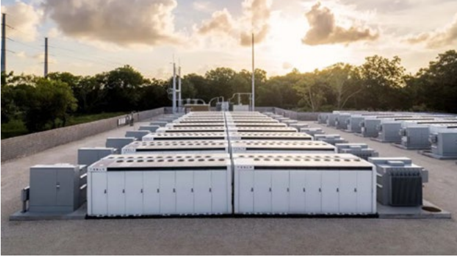
Les accumulateurs de réseau plus grands sont construits de manière modulaire. Plusieurs entreprises proposent des modules de la taille d'un conteneur, chacun avec une capacité d'environ 5 MWh. Ceux-ci sont regroupés en fermes de stockage. Photo de gauche : Tesla MEGAPACK ® . Photo de droite : BYD CUB ® .
