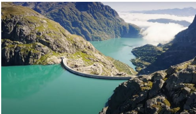
Photo de gauche : Centrale de pompage-turbinage de Nant de Drance. Lac supérieur Vieux Emosson, 2'225 m (25 millions de m 3 d'eau, 20 GWh de stockage électrique). Lac inférieur : Lac d'Emosson, 1'930 m. Photo de droite : la centrale de pompage-turbinage de Linth-Limmern est la plus grande de Suisse. Le lac de Mutt, 2'474 m (23 millions de m 3 d'eau, 33 GWh de stockage électrique) est le lac de retenue le plus haut d'Europe. Lac inférieur : Limmerensee, 1'857 m (photos et chiffres ) 3
