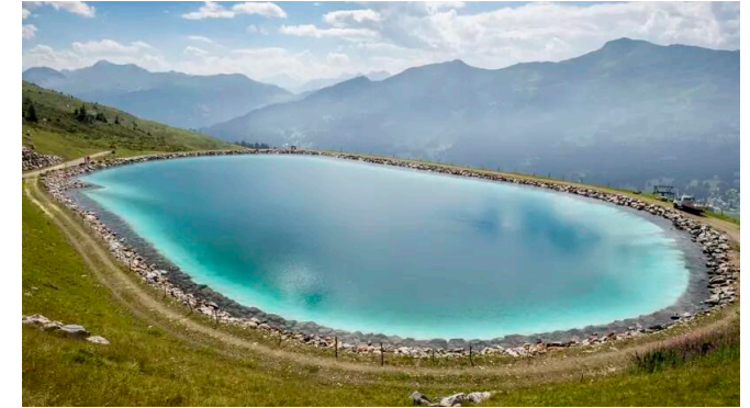
Lac de stockage d'eau pour les installations d'enneigement (pistes de ski)
