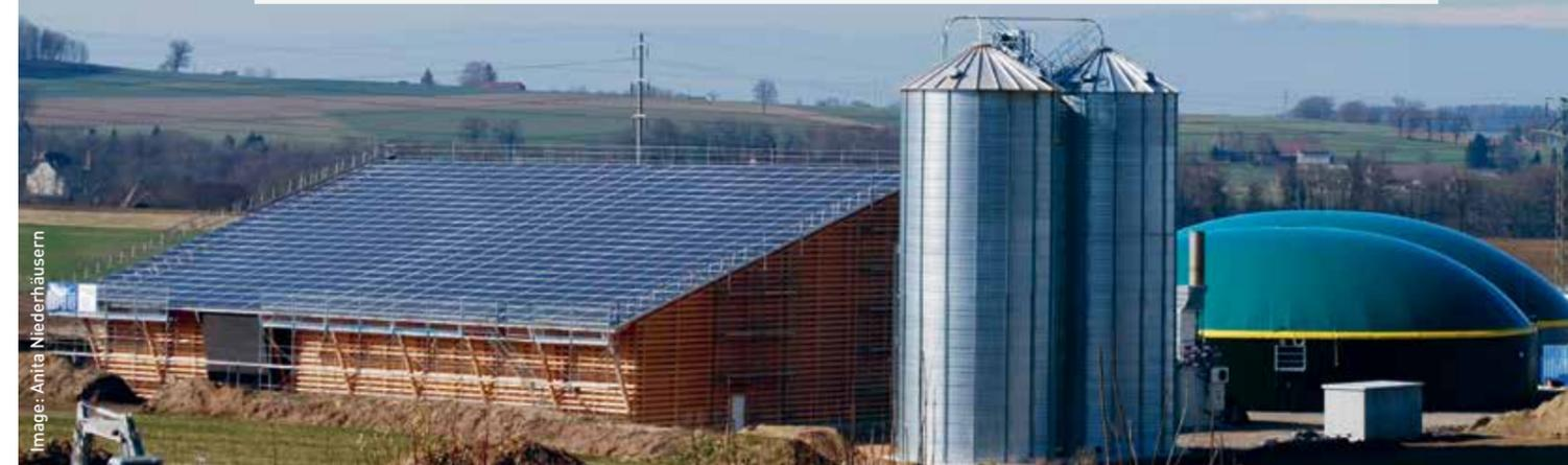
On pourrait encore accroître d'un tiers la consommation de bois énergie. Des granulés sont produits dans cette halle à partir de bois des forêts de la région. Une installation de biogaz fournit de la chaleur pour le séchage du bois, tout comme la chaleur sous l'installation d'électricité solaire aménagée sur le toit.
