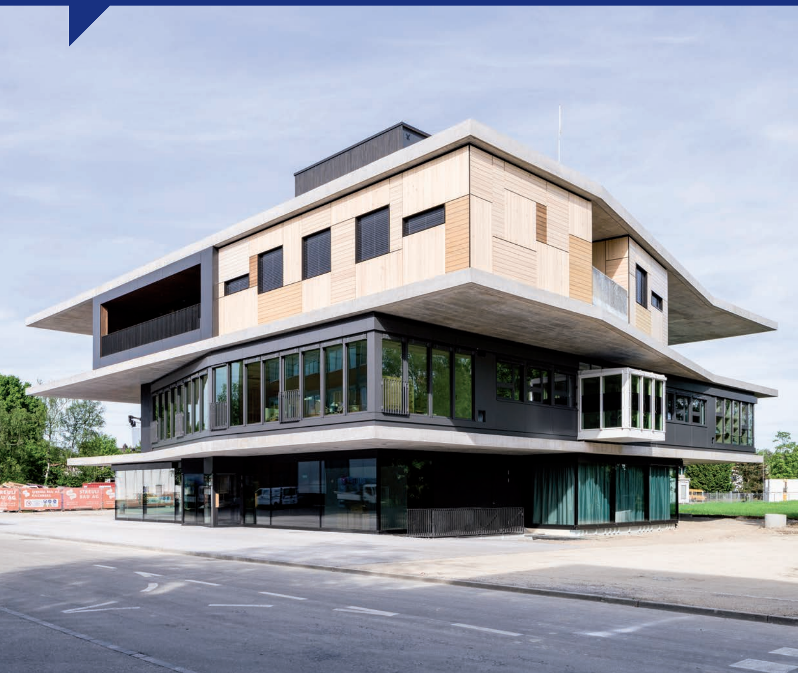
Das NEST, die «Plattform für experimentelles Wohnen und Arbeiten» auf dem Gelände der Empa in Dübendorf, wurde im Mai 2016 eröffnet. Darin werden dereinst rund 50 Personen wohnen und arbeiten. Im modularen Gebäude werden Verfahrens- und Materialinnovationen getestet und so schneller zur Marktreife gebracht. (Bild: Empa / Roman Keller)
