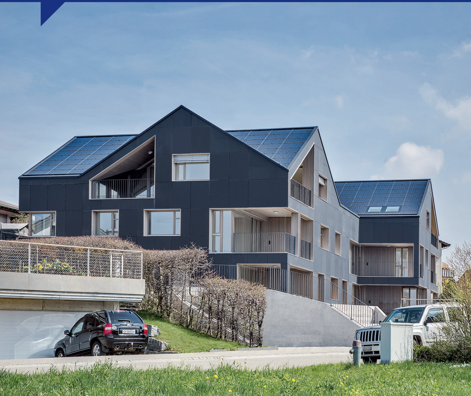
Das im Juni 2016 eingeweihte Mehrfamilienhaus in Brütten beweist, dass ein Gebäude dank Photovoltaik, verschiedenen Speichern und Wärmepumpe ohne externe Energiezufuhr funktioniert. Das Haus ist ein Projekt der Umwelt Arena AG Spreitenbach. (Bild: Umwelt Arena AG)
