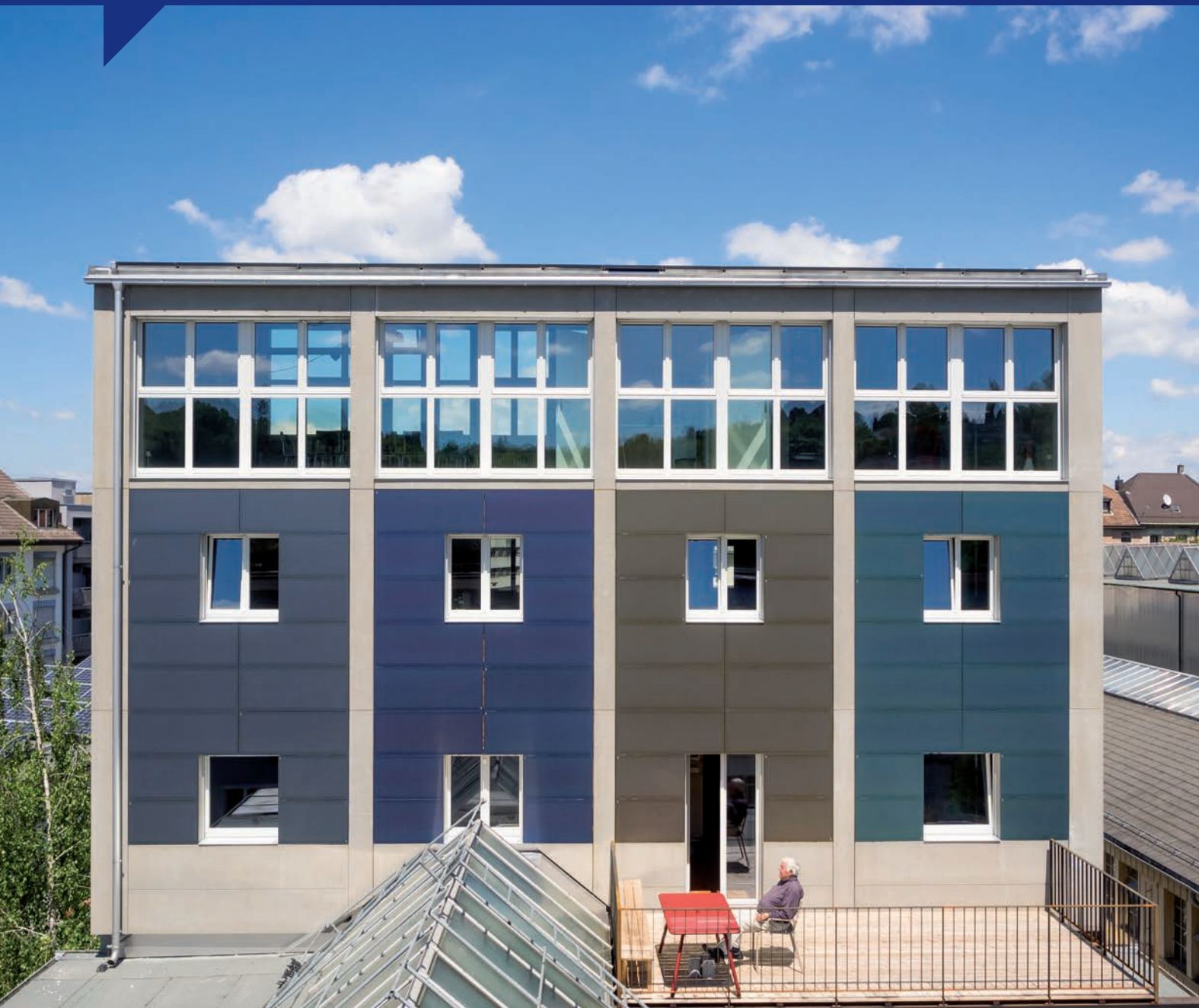
Das ehemalige Kohlesilo im Basler Gundeldinger Feld ist mit zwei Fassaden-PV-Anlagen ausgerüstet. Deren Module mit satinierten verschiedenfarbigen Glasplatten bieten neue architektonische Möglichkeiten. Das Gebäude wurde mit dem Solarpreis 2015 ausgezeichnet. (Bild: Solvatec AG)
