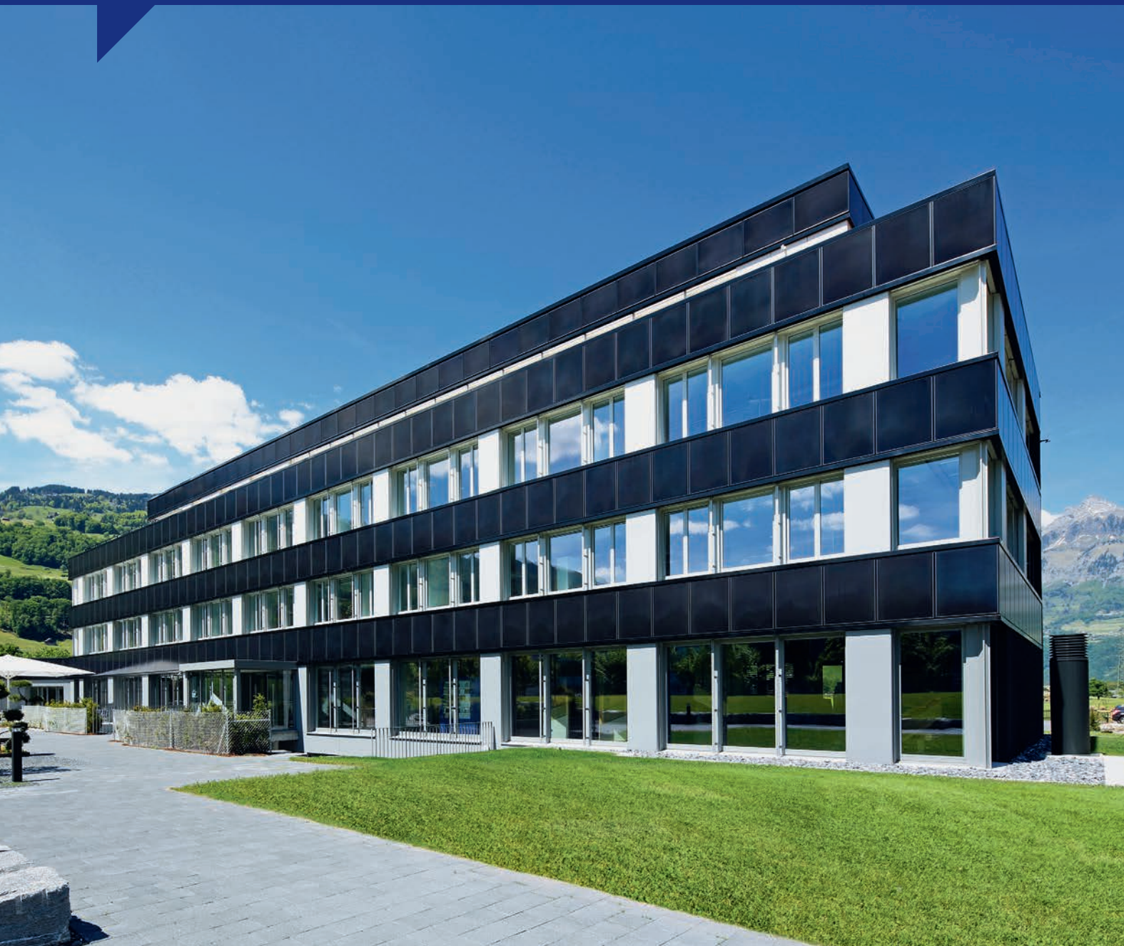
Die Sanierung des Flumroc-Hauptsitzes machte aus dem 30-jährigen Gebäude ein Plusenergie-Vorzeigeeobjekt. Das Bürohaus erzeugt mehr Energie, als es verbraucht. Der Komfort für die Nutzer wurde mit minimalen Eingriffen erhöht und das Gebäude optimal gedämmt, Dach- und Fassadenanlagen liefern den Strom. (Bild: Flumroc AG)
