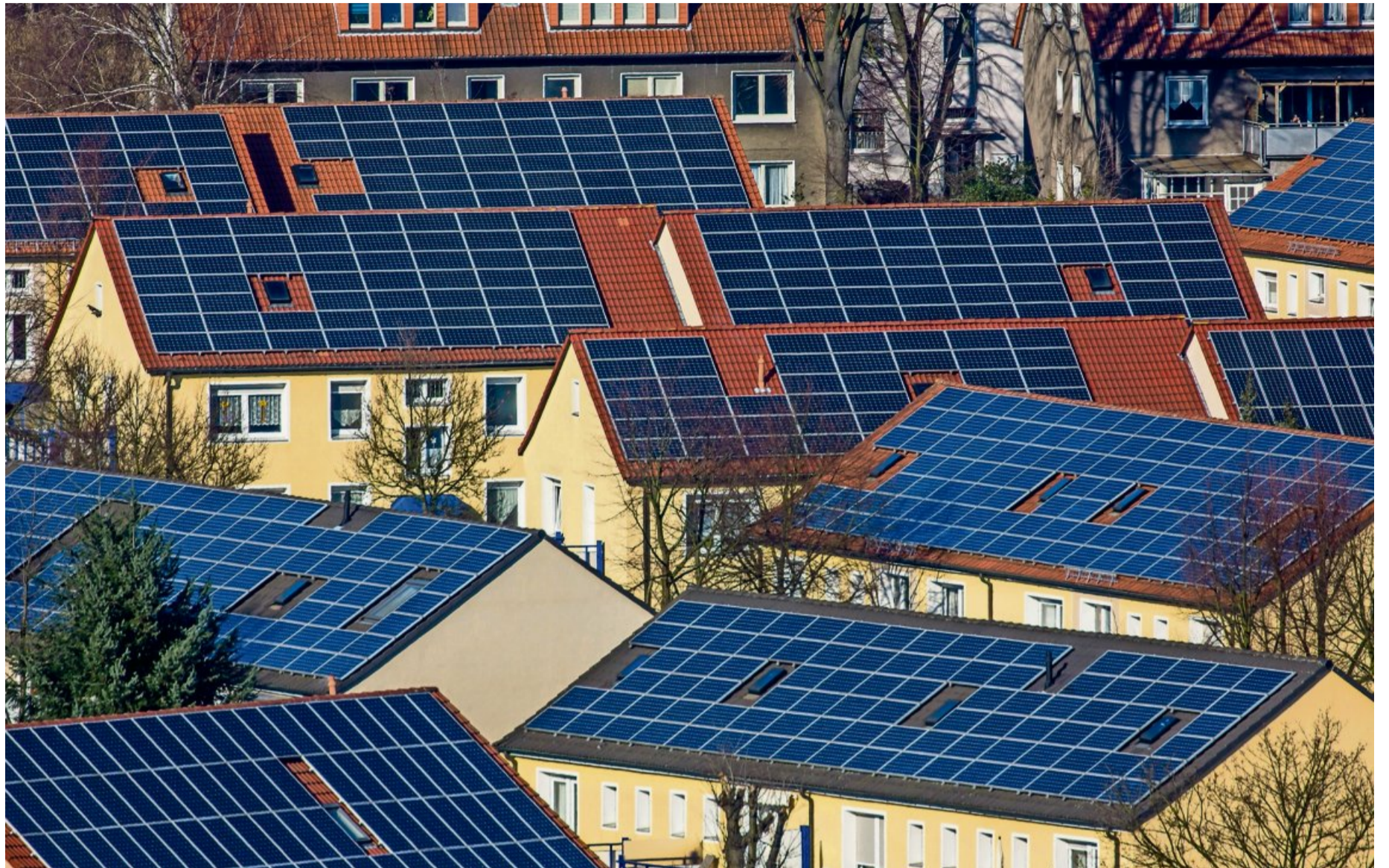
Sonnenstrom vom Dach: Speichern Hausbesitzer diesen in einer eigenen Batterie, können sie mehr davon nutzen und gleichzeitig Netzschwankungen auffangen.
