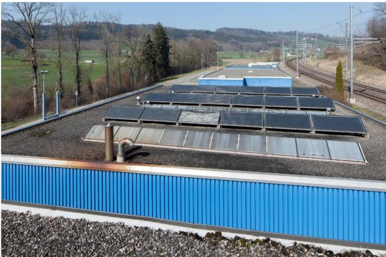
Vorher: Ein Glasbruch setzte die alte Sonnenkollektor-Anlage ausser Betrieb und gab den Impuls zu einer Sanierung.
